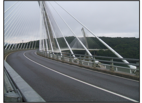
Le nouveau pont suspendu
